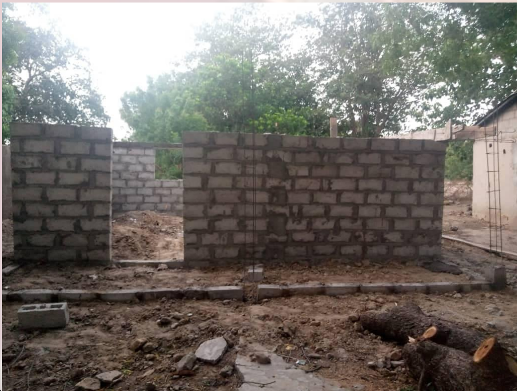
Foto: Es geht schnell voran: Das Mauerwerk für die neue Schulküche steht schon.
