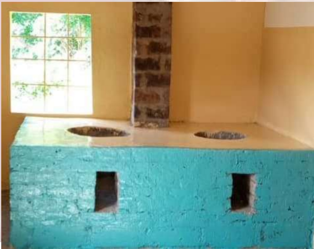
Foto: Der Ofen funktioniert ist nach den lokalen Gegebenheiten angepasst, ohne Elektrizität. Ein offenes Feuer kann hier jedoch nicht mehr entstehen.
